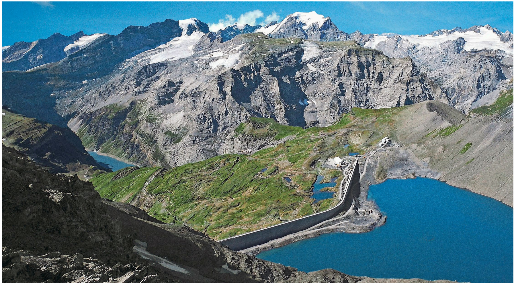
Axpo-Pumpspeicherwerk Limmern: Die Pumpspeicherung ist eine bewährte Methode, um Angebot und Nachfrage in einem Stromnetz auszugleichen.
